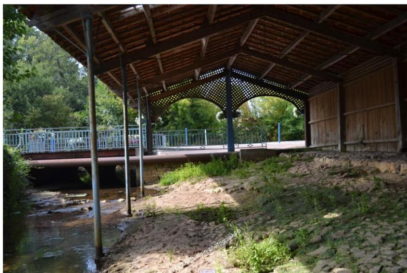
Les pavés et l'empierrement formant la pente authentique du lavoir ont partiellement été emportés lors des crues de la Jalle (en 1981 notamment). Aujourd'hui encore, les crues hivernales continuent d'altérer la partie maçonnée de l'ouvrage dans la mesure où le niveau haut de la Jalle affleure le dessous de pont en amont du lavoir.
