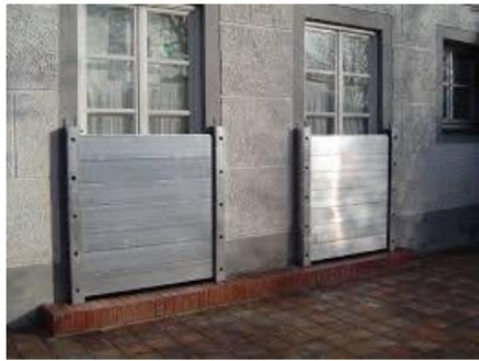
Exemples de batardeaux amovibles ou de portail contre les inondations
