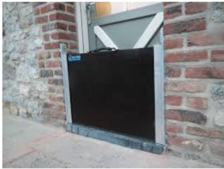
Exemples de batardeaux amovibles ou de portail contre les inondations
